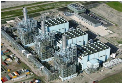
Conversion d'un des 3 CCG de Nuon (Vattefall) à l'hydrogène pour 2023 par Mitsubishi, à Eemshaven (Pays Bas)
